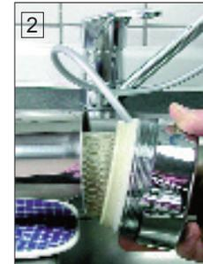
2. Den verbrauchten Filtereinsatz durch Herausziehen entnehmen. Anschließend das Filtergehäuse innen mit heißem Wasser, verdünntem Essigwasser, oder mit Spülmittel gut reinigen.
