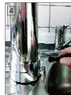
4. Dann drücken Sie das Filtergehäuse fest auf den Gehäusefuß, schieben den Gehäuse ring wieder über das Gehäuse und drehen diesen mit dem Steckschlüssel rechtsdrehend handfest an.
