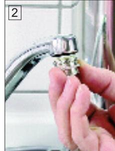
2. Hat der Siebeinsatz (Perulator) auf Ihrer Armatur ein Innengewinde, dann schrauben Sie zuerst den Gewinde-Adapter, welcher mit dem Filter mitgeliefert wurde, mit dem Filter mitgeliefert wurde, mit der Gummidichtung ein und ziehen ihn fest.
